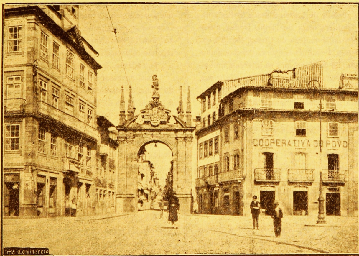
BRAGA — Arco da chamada Porta Nova. — E' a entrada da cidade para quem vem da estação do Caminho de ferro. — E' obra do Arcebispo D. Diogo de Souza
