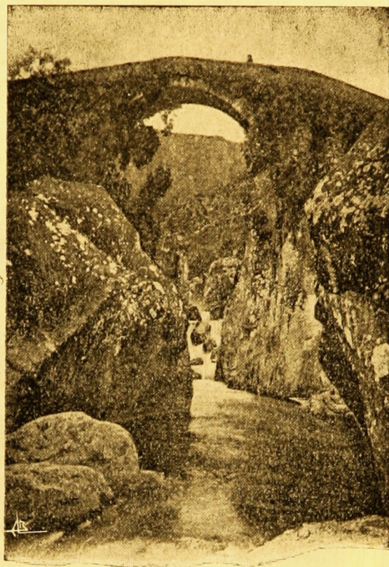
VIEIRA DO MINHO — Ruivães — Ponte da Misarela.
