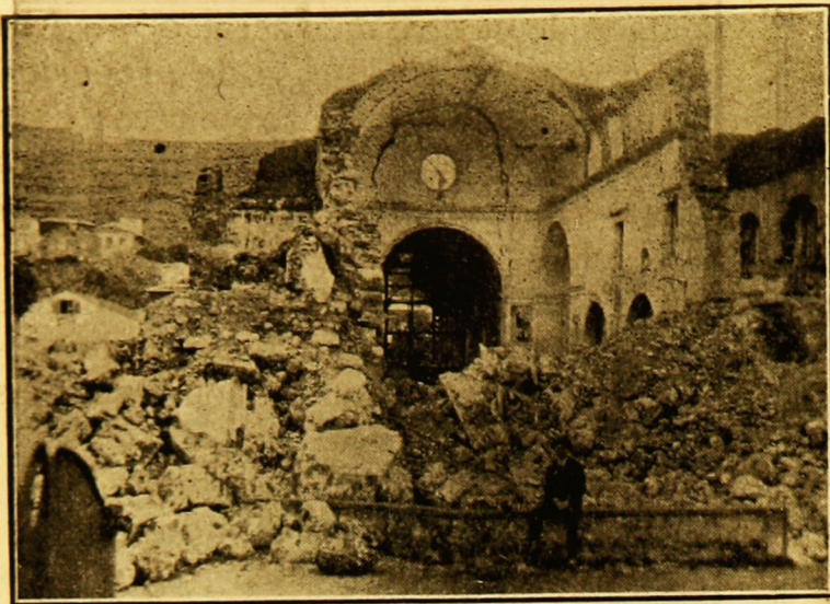
FAIAL. — Uma historica igreja, completamente destruida pelo terremoto
