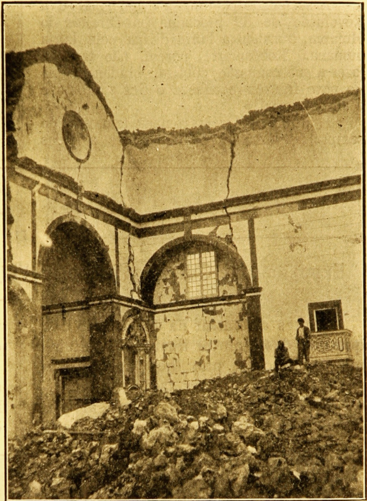
FAIAL. — Templo destruido pelo terremoto.
