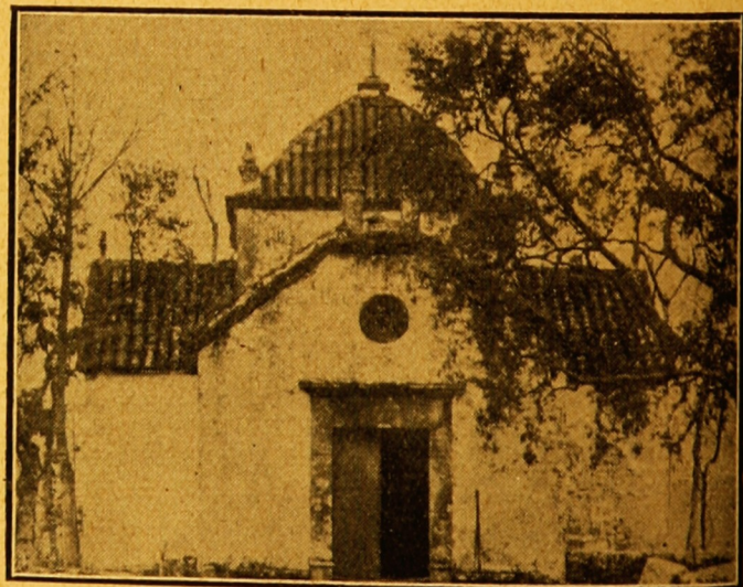
S. NICOLAU. — Capela da Casa da Taipa.
