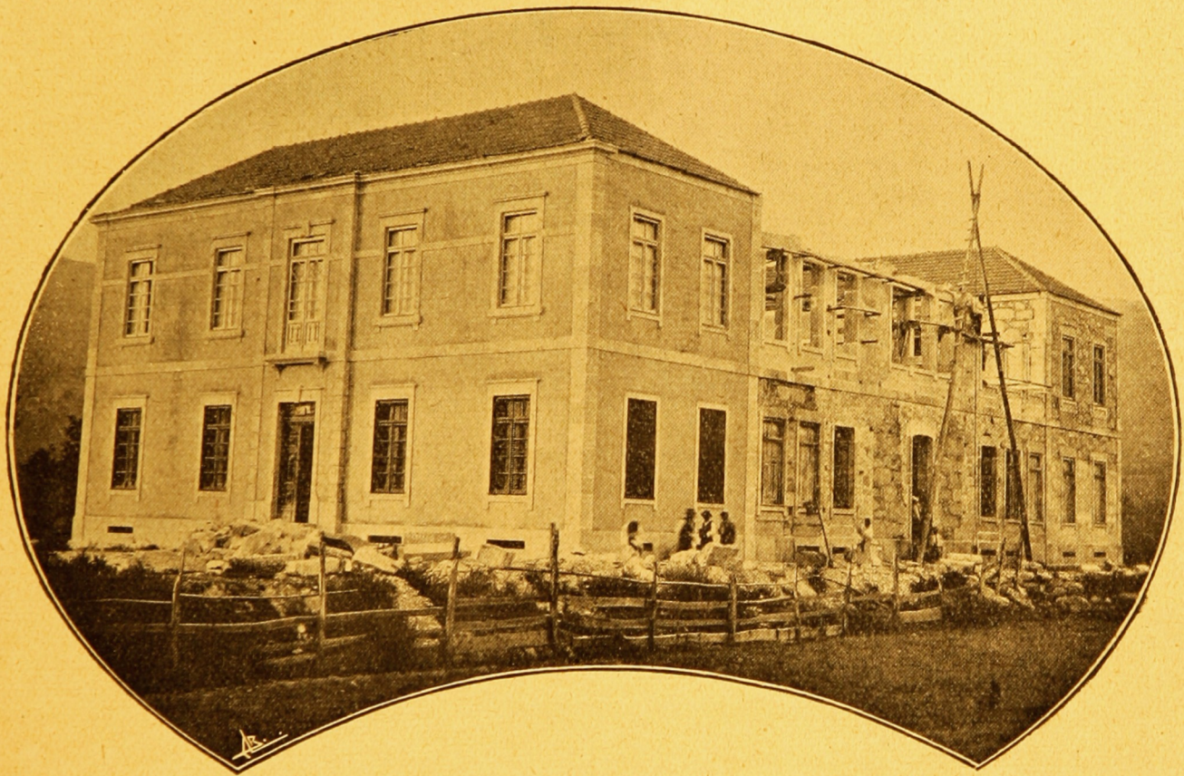
O HOSPITAL. — Estado das obras em 1923.
