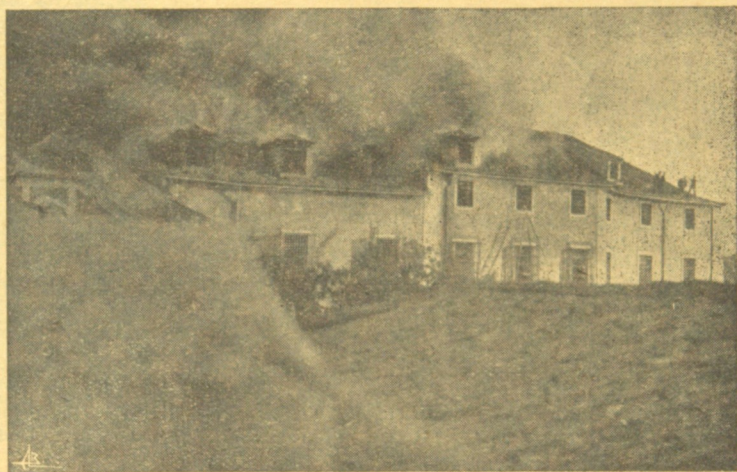
Um aspecto do incendio no Limoeiro.
