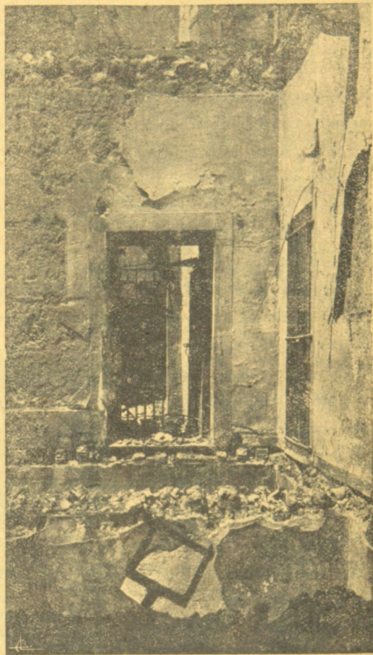
Incendio do Limoeiro. — Os escombros.
