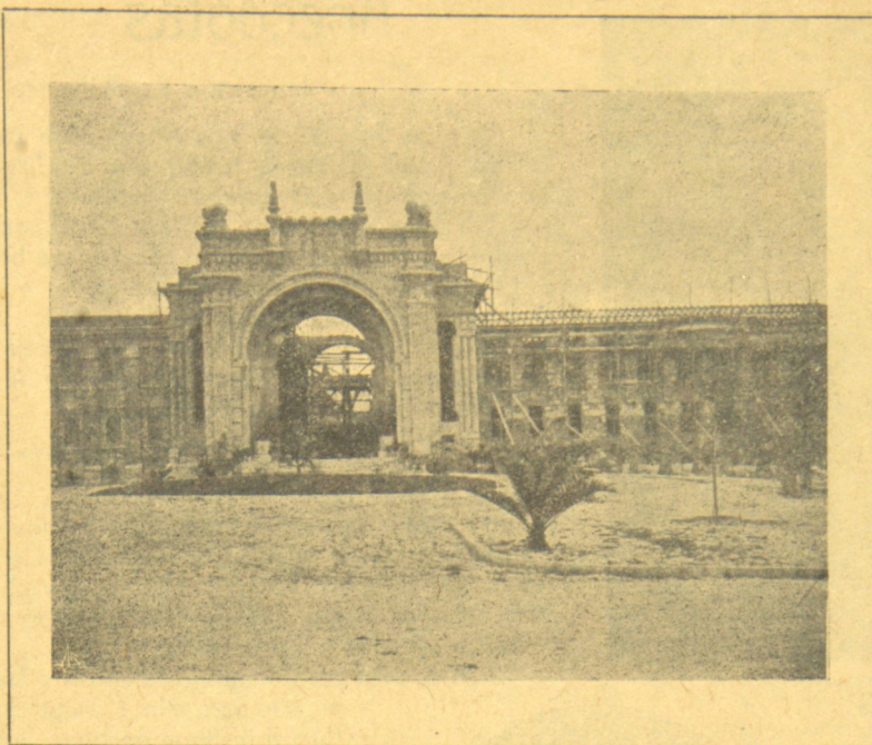
Estoril — Balneario (em construção).
