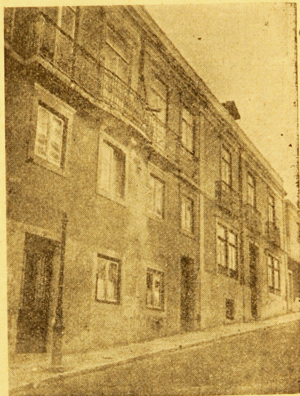
A sacada d'un prédio destruída por uma granada
