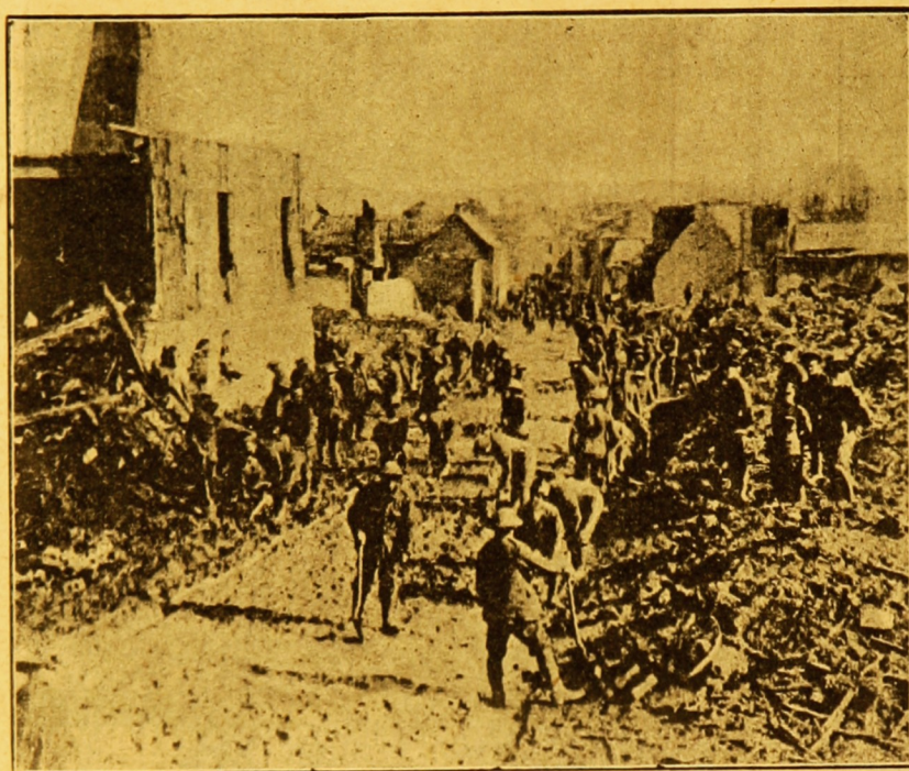
Sapadores construindo uma estrada atravez das ruinas de uma povoação
