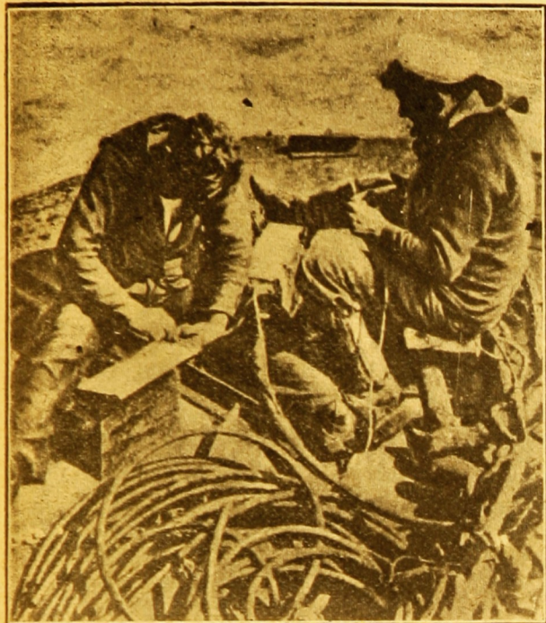
Ligação de baterias electricas entre minas e a rede
