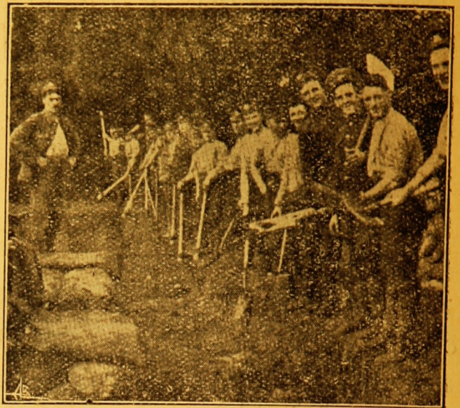
Abrindo a trincheira
