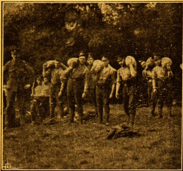
Construindo trincheiras.—Soldados carregando com saccos de ariz para o parapeito das trincheiras.
