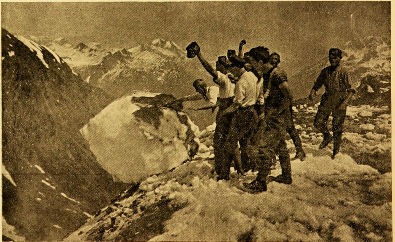
Soldados suissos lançando bolas de neve de cima d'uma grande montanha coberta de neve
