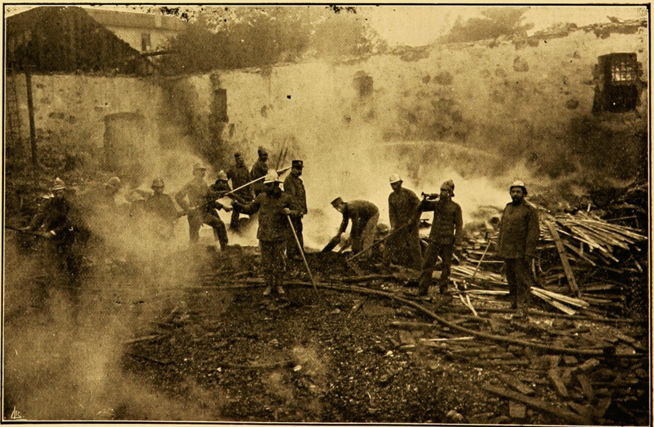
O lado norte que foi totalmente destruido
