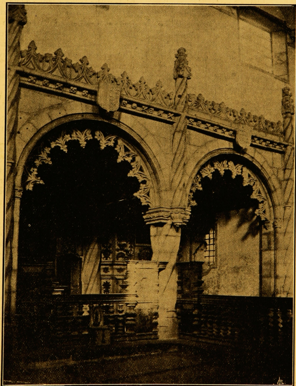
PONTE DO LIMA—Capella da Senhora da Piedade e da Senhora da Soledade na igreja de Santo Antonio dos Frades Capuchos
