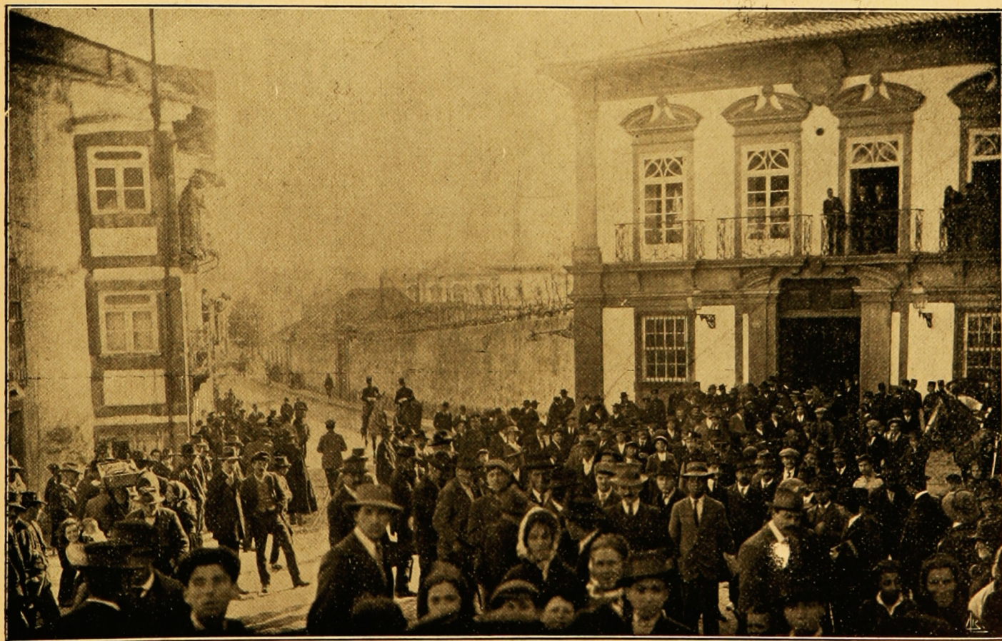
BRAGA—O Paço dos Biscainhos onde se realisou a grande reunião monarchica. O povo sahindo do edificio
