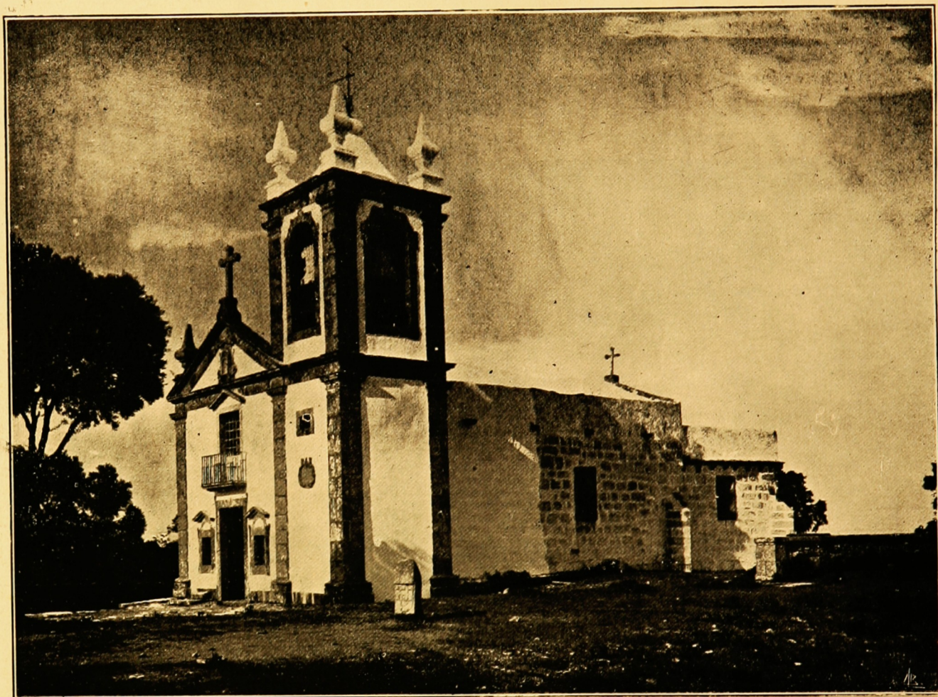
BARCELLOS—Ermida da Nossa Senhora da Franqueira
