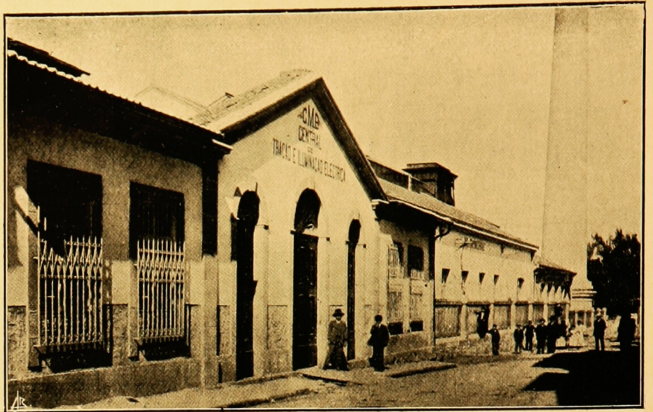
Edificio da Central de tracção e illuminação electrica
