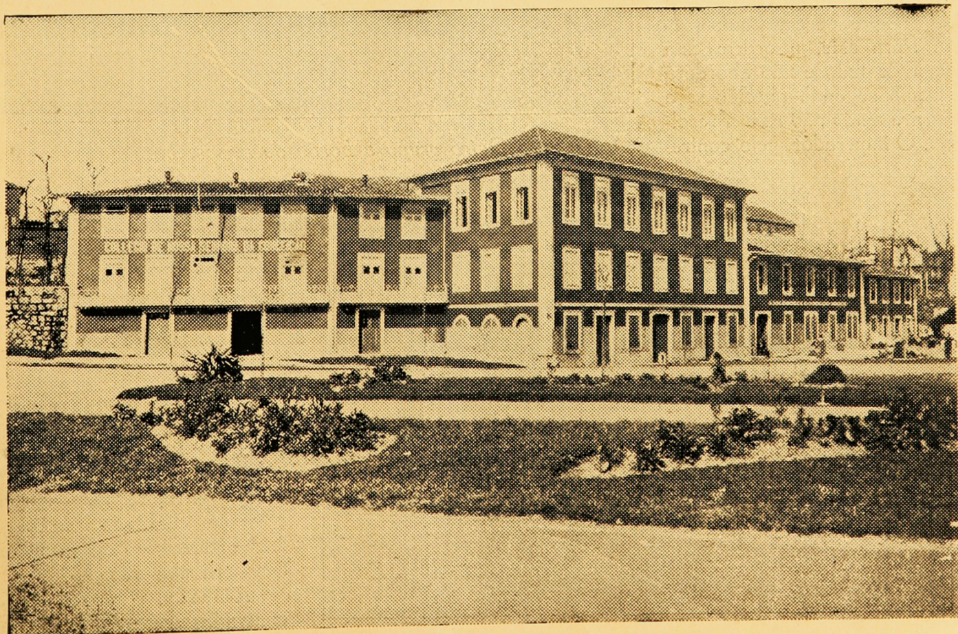
GUIMARÃES — Edificio do Collegio de Nossa Senhora da Conceição
