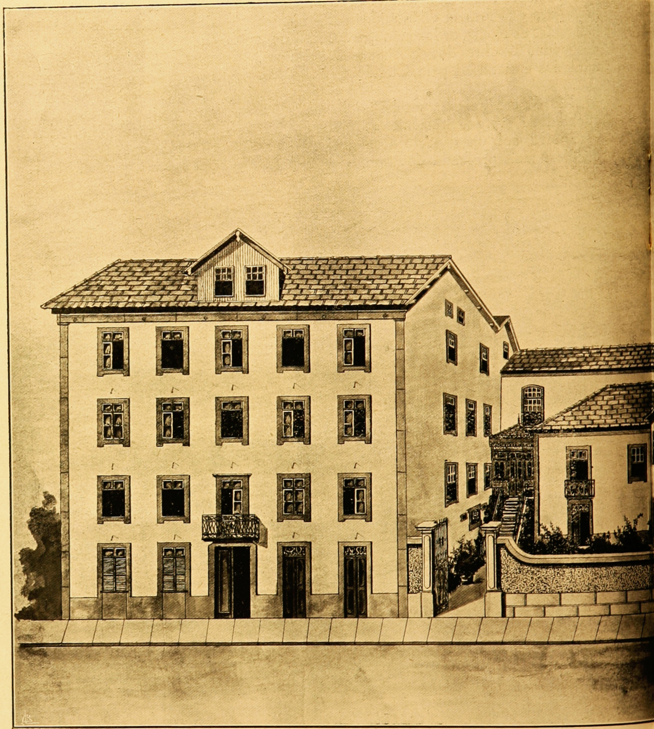
Vista geral do grande edificio do
