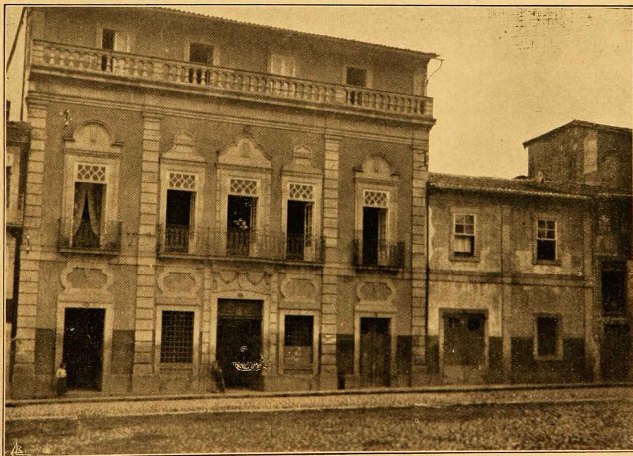
Edificio da Escola Academica (Largo de S. Bento)
