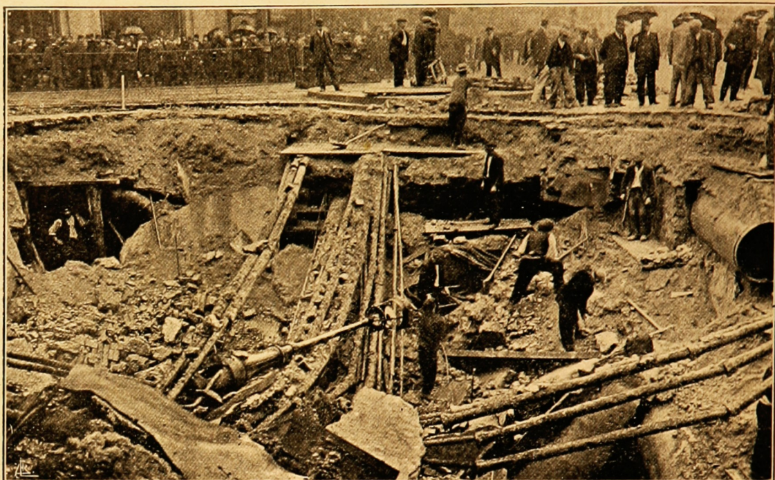
PARIS—Horriavel catastrophe. Profundas excavações da rua do Havre, onde pereceram muitas pessoas
