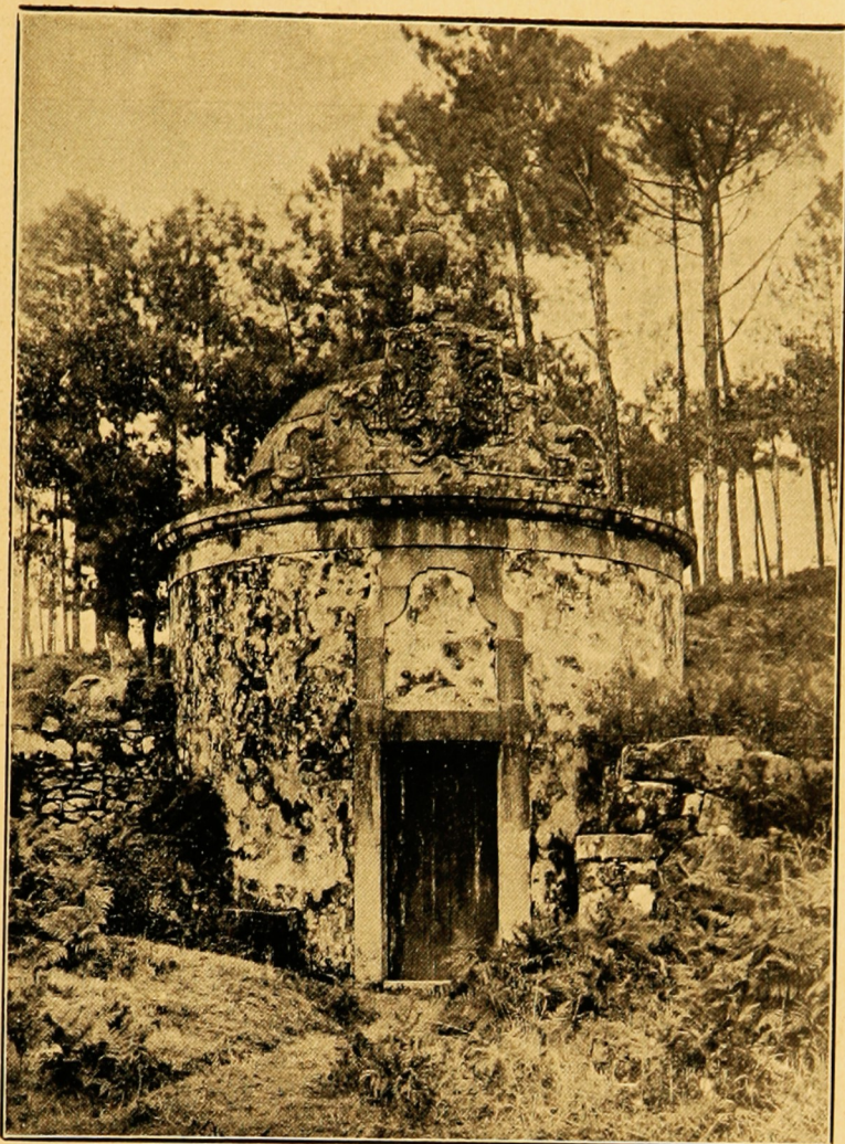
Um dos primitivos depositos para o abastecimento das aguas nas Sete-Fontes, obra do Arcebispo e Senhor de Braga D. José de Bragança
