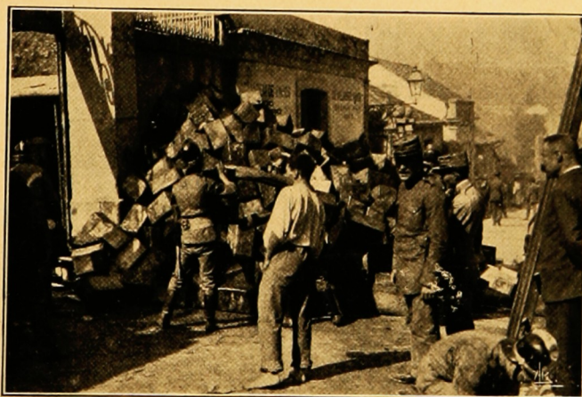
Latas de gazolina inutilisadas pelo incendio
