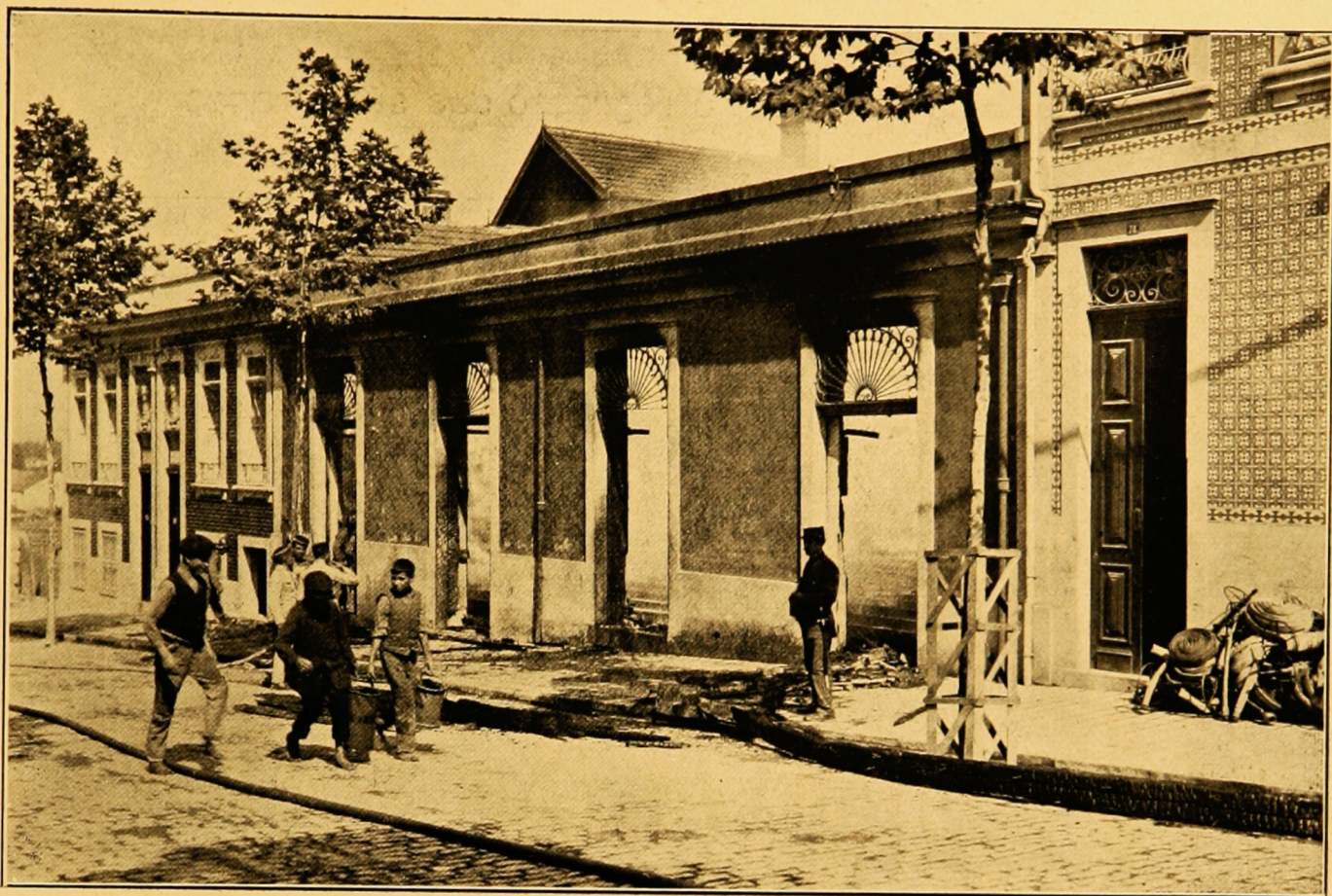
Fachada do predio incendiado.
